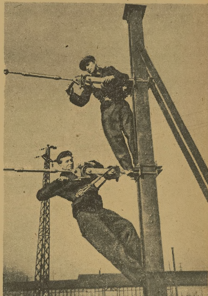
Obecnie trwają intensywne prace przy dalszej elektryfikacji warszawskiego węzła kolejowego. Na zdjęciu: monterzy Stefan Kielbaso i Henryk Biernat przy montażu wentkówek sieci trakcyjnej. Foto CAF — Wdowiński
