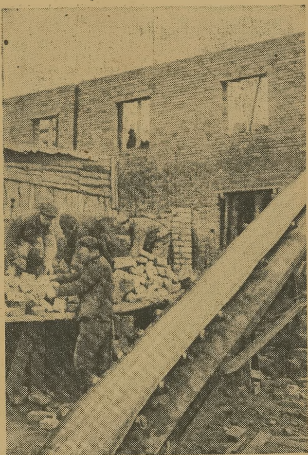
W szybkim tempie przebiegają prace przy budowie Marszałkowskiej Dzielnicy Mieszkaniowej. Wszystkie budowy MDM przygotowują się do prowadzenia robót zimą. Na zdjęciu: zespół Jerzego Jasieńskiego z bloku 6-b przy budowie pieca do ogrzewania zwiru.
