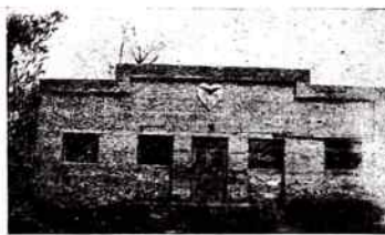
Budova kvasilovského SOKOLA.
