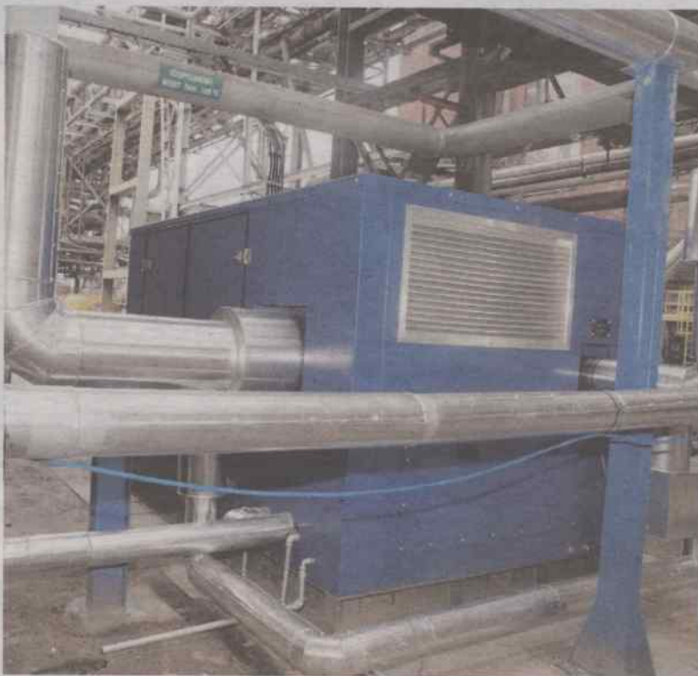
Tak prezentuje się prądotwórczy rozprężacz śrubowy zamontowany przez ZAMKON na terenie Grupy Azoty Kędzierzyn.
