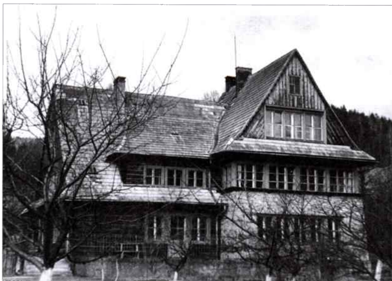
Fot. 5. Plebania w Skomielnej Czarnej wybudowana w latach 1949–1950 przez o. Remigiusza Kranc.
