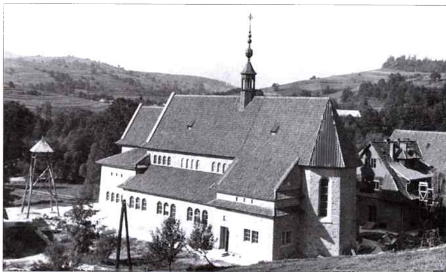
Fot. 11. Kościół w Tenczyne wybudowany w latach 1959–1970. W latach 1967–1970 pracami kierował o. Remigiusz Kranc. Kościół został poświęcony 18 października 1970 roku.
