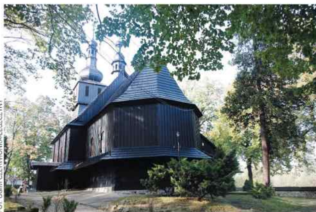
Kościół pw. Św. Marii Magdaleny czeka jeszcze na dokończenie prac konserwatorskich i wykonanie instalacji elektrycznej, alarmowej i przeciwpożarowej
