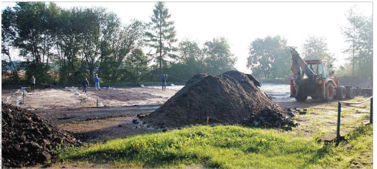
Prace na terenie nowych boisk trwają. Obiekty będą gotowe w najbliższych miesiącach.
