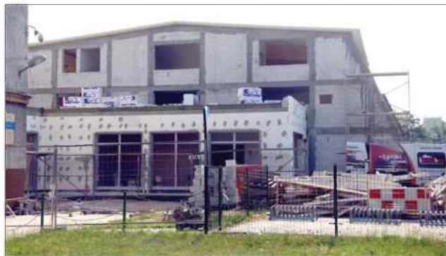
W części frontowej trwa już ocieplanie budynku
