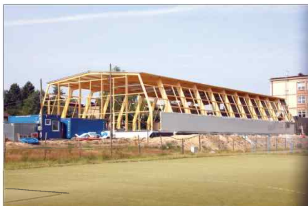
Obiekt coraz bardziej przypomina budynek z projektu
