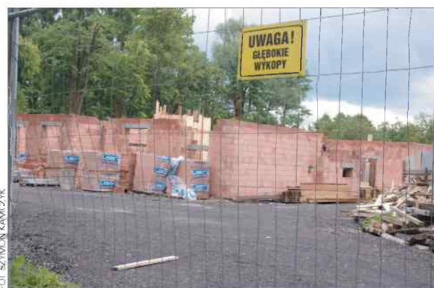
Obecnie nowe przedszkole ma już ściany na poziomie parteru, a wykonawca przygotowuje się do wykonania stropu
