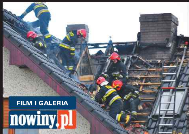
Strażacy rozbierają spaloną konstrukcję dachu
