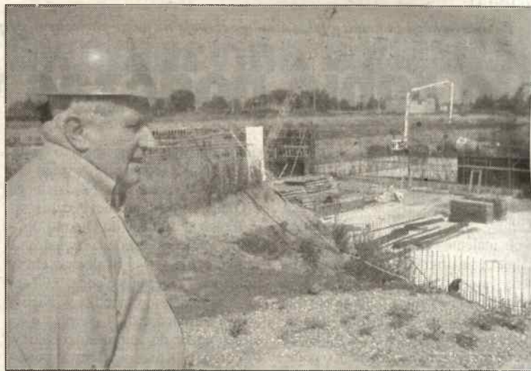
„Budowa idzie zgodnie z planem” - mówi jej kierownik B. Gawron
