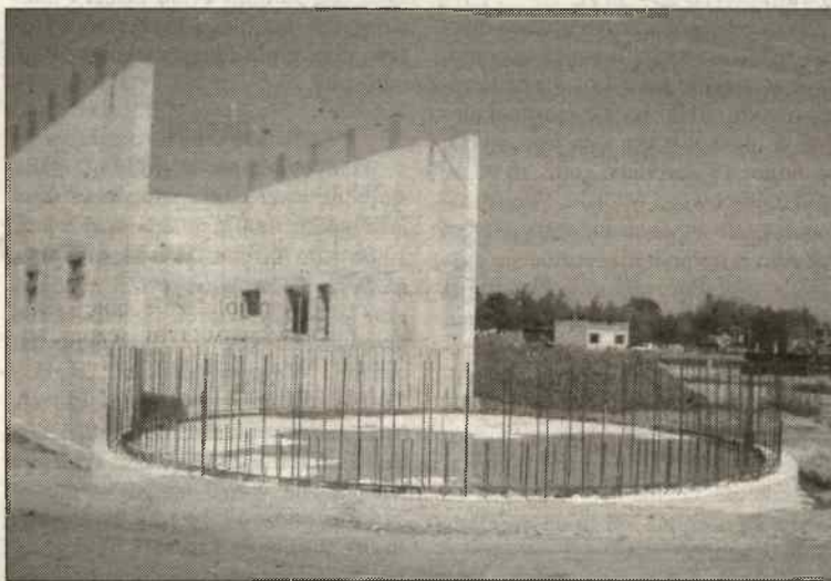
Pomieszczenie aerotermu jeszcze w budowie
