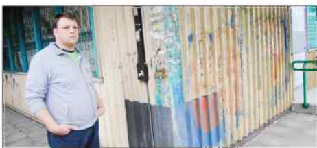
Mieszkańcy walczą o remont pawilonu przy ul. Wandy
