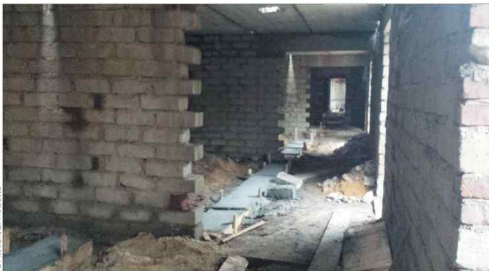
Stare fundamenty okazały się bardzo solidne, więc budowa ruszyła pełną parą
