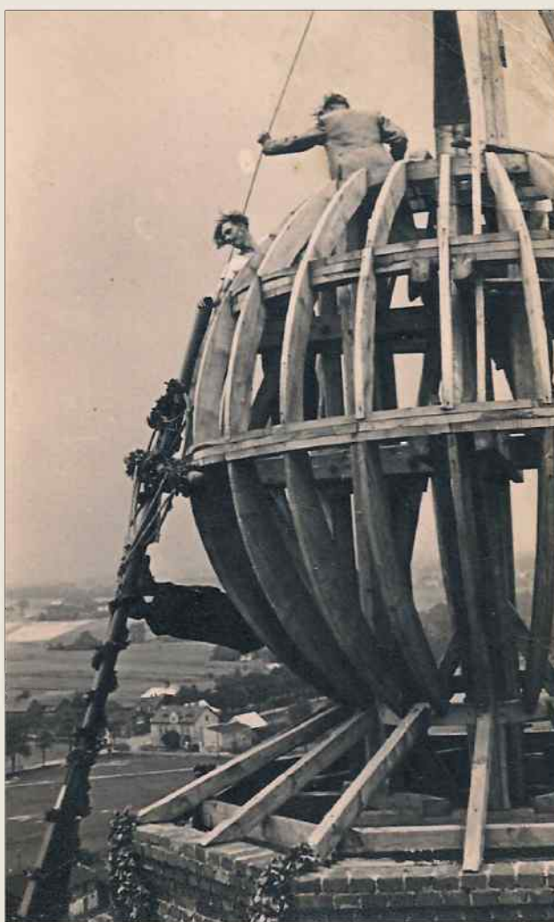
Budowa kościoła w Czernicy
