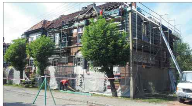
Ekipy remontują dach, który finansują mieszkańcy familoka
