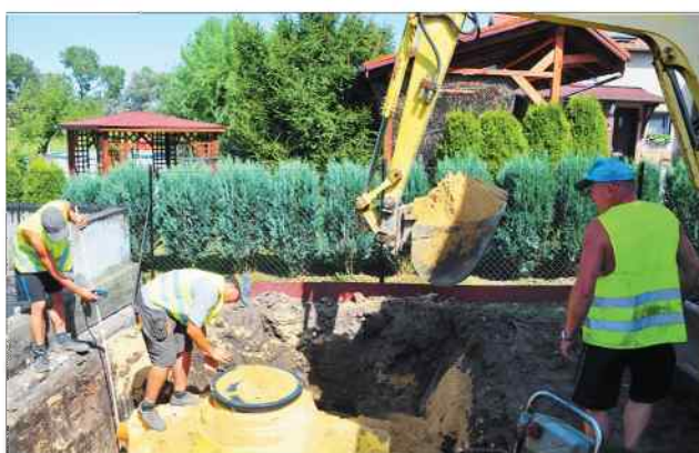
– Zamontowanie oczyszczalni na terenie posesji trwa jeden dzień
