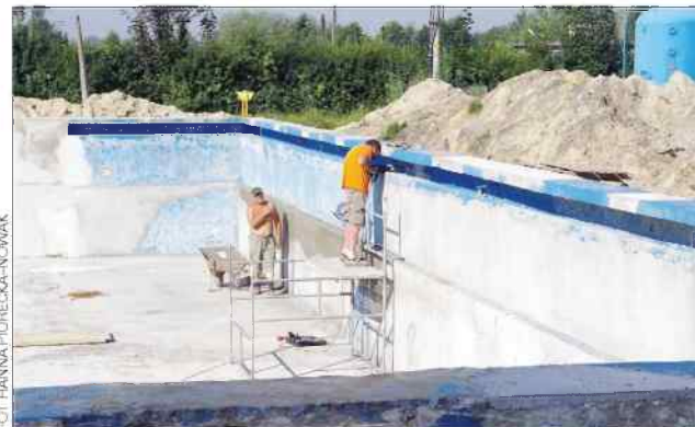
Na terenie kąpieliska w parku Furgoła ekipy remontowe kończą prace na płycie dennej dużego basenu
