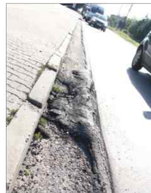
Po dwóch godzinach po śródownym remoncie droga wyglądała już jak wcześniej
