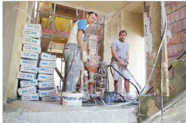
Obecnie, wewnątrz budynku starej szkoły trwają już prace wykończeniowe
