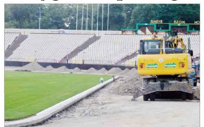
Budowlancy zdzierają całą warstwę sjenitu z starego toru
