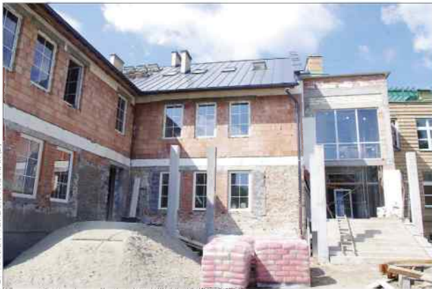
Ekipy remontowe pracują pełną parą, by jesienią mali leszczynianie mogli wrócić w stare-nowe mury
