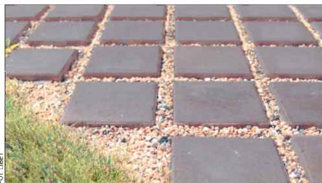
Dzięki wypustkom dystansującym na kostkach ekologicznych po ich ułożeniu powstają szerokie spoiny, które można wypełnić drobnym żwirem
