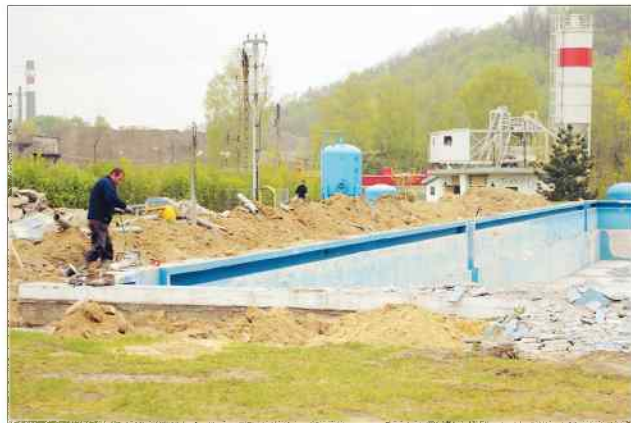
Robotnicy rozebrali już dno basenu i zabrali się za odkuwanie luźnych warstw betonu na ścianach
