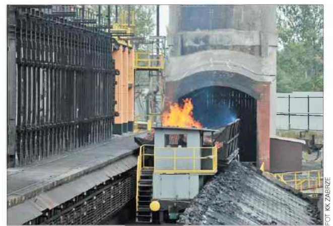
Jedna ze stacji do monitorowania substancji emitowanych przez koksownię w połowie roku powstanie na terenie zakładu
