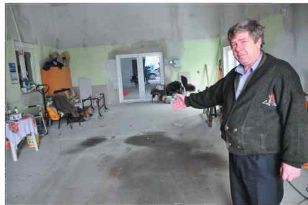
Na budowie panuje jeszcze bałagan, ale to w tym pomieszczeniu staną piece krematoryjne. Na zdjęciu Adam Rosół.
