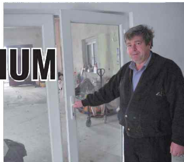
Na budowie panuje jeszcze bałagan, ale to w tym pomieszczeniu staną piece krematoryjne. Na zdjęciu Adam Rosół.
