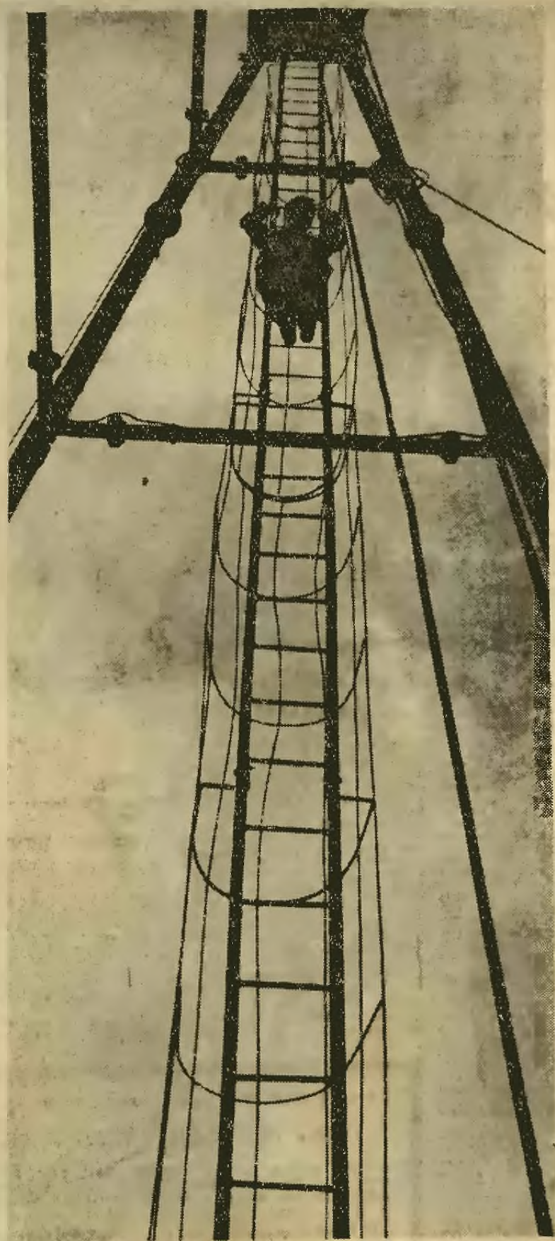
Wieża wiertnicza kop. „Moszczenica”
