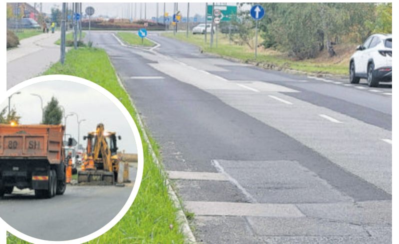
W pierwszym etapie ekipy budowlane zajmą się terenem przy drodze, a później samą jezdnią ul. 26 Stycznia / fot. Tomasz Czarnecki
