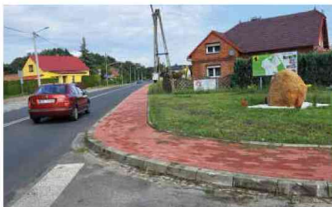
Stare Koźle - nowy chodnik przy drodze 408
