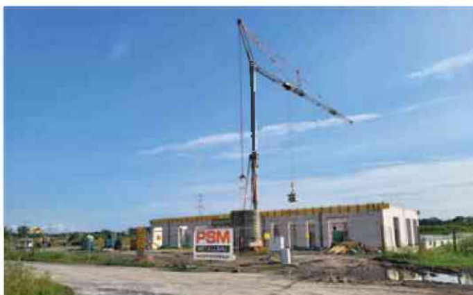
Stare Koźle - budowa siedziby nowego inwestora
