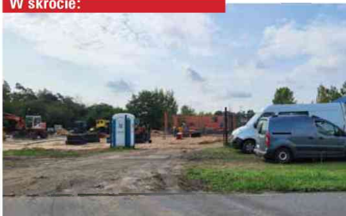
Bierawa - budowa myjni i stacji benzynowej
