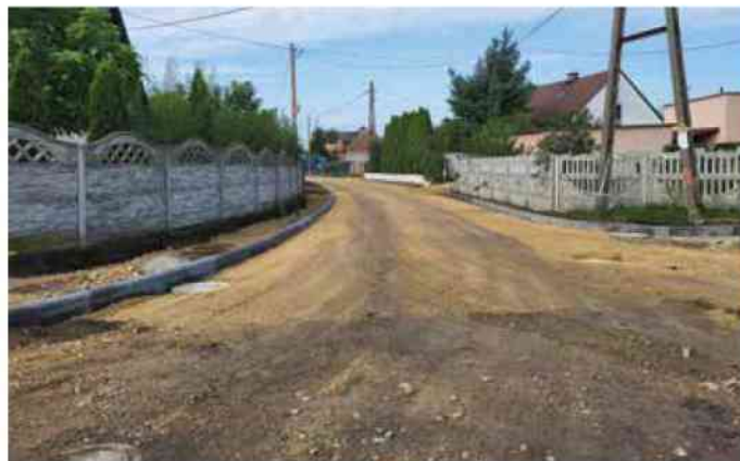
Bierawa - budowa nowej nawierzchni na ul. Ogrodowej
