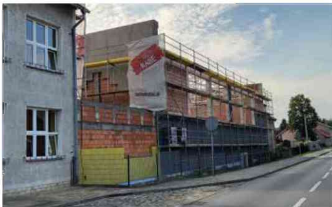
Dziergowice - budowa nowej sali gimnastycznej
