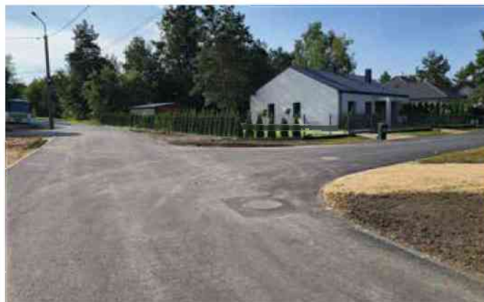
Stara Kuźnia - budowa ul. Okrężnej
