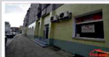
LOKAL UŻYTKOWY NYSY, UL. SOBIESKIEGO 43m2, parter, Co miejskie, Centrum
