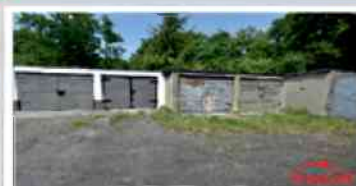
GARAŻ NYSY UL. BOLESŁAWA ŚMIAŁEGO 18m2, w segmencie, kryty papą, kanał
