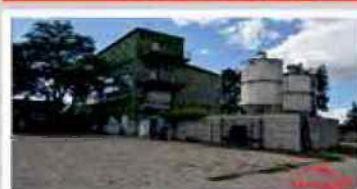
BUDYNEK USŁUGOWO - BIUROWY SKOROSZYCE UL. DZIAŁKOWA 64ar, 300m 2 , teren utwardzony
