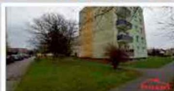
MIESZKANIE 2 POKOJOWE NYSA UL. KEN 48m 2 , IV piętro, Co węglowe, balkon
