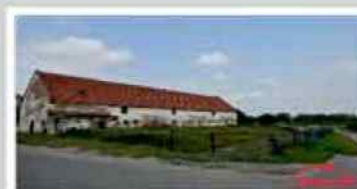
DZIAŁKA BUDOWLANA MAKOWICE
