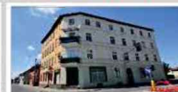
MIESZKANIE 3 POKOJOWE NYSA UL. PIŁSUDSKIEGO 64m 2 , II piętro, Co gazowe, czynsz 430zł
