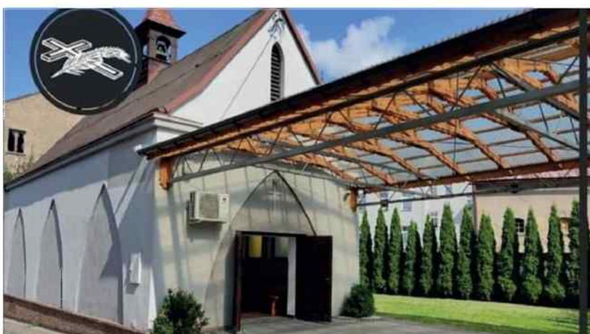
KAPLICA KIETRZ UL. SZPITALNA 2
