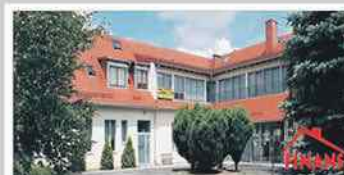
BUDYNEK USŁUGOWY NYSA UL. KRASIŃSKIEGO 35,74ar, 1630m2, Co gazowe
