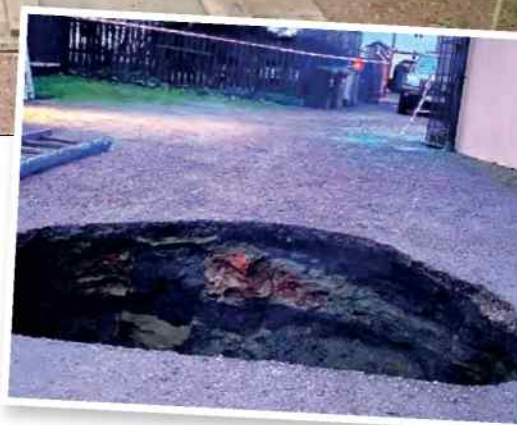
■ Dziurę w ziemi zabezpieczyli strażacy. Prawdopodobną przyczyną powstania zapadliska było wypłukanie gruntu przez wody podziemne. FOT. KM PSP JASTRZĘBIE-ZDRÓJ
