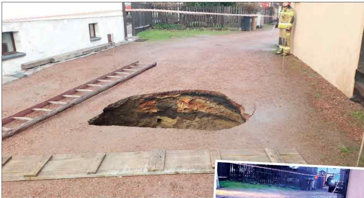
■ Dziurę w ziemi zabezpieczyli strażacy. Prawdopodobną przyczyną powstania zapadliska było wypłukanie gruntu przez wody podziemne. FOT. KM PSP JASTRZĘBIE-ZDRÓJ
