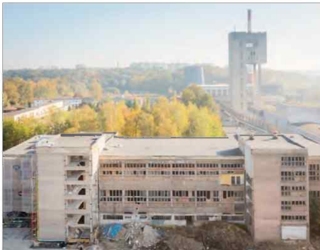
■ Budynek modernizowanej łaźni Moszczenica
