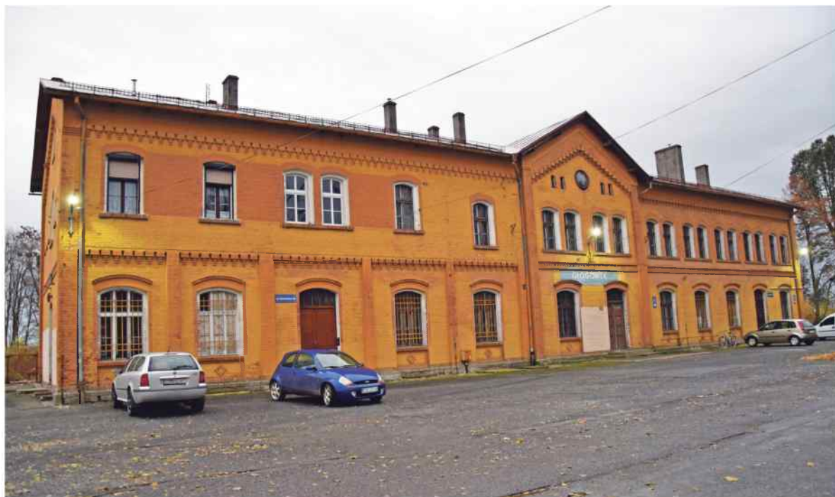
Gmina wystąpiła do PKP o przejęcie części działek przy dworcu w Głogówku.
