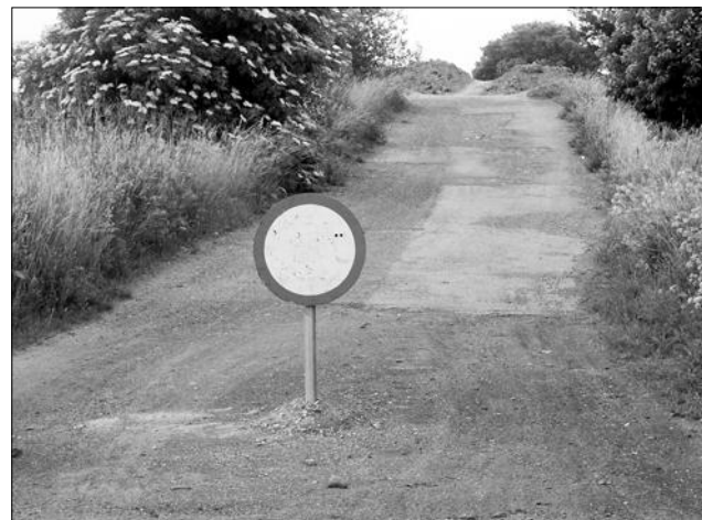
Władze Lubomi zamknęły zniszczony most dla ruchu
