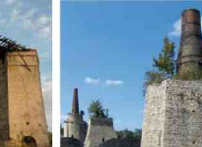
Krapkowice - Zespół pieców / Kiln Complex / Ofenkomplex
