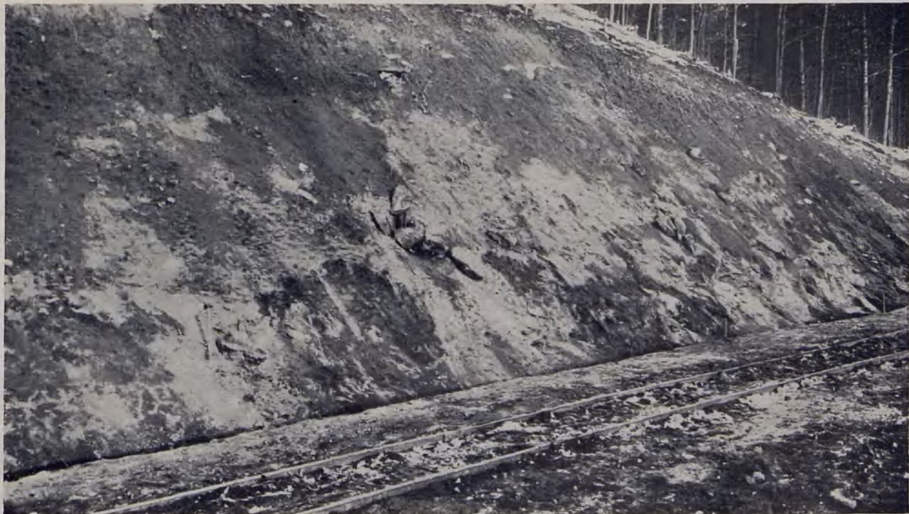
Chausseebau Steinkirch-Pogarth, Kreis Strehlen. Abgesprengter Felskegel bei Stat. 4.8. Ausführung: Johann Kohla
