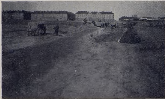
ERDARBEITEN WITOWSKISTR., GLEIWITZ
