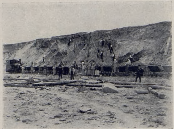
Bau der Sandversatzbahn Niebowitz—Knurow
