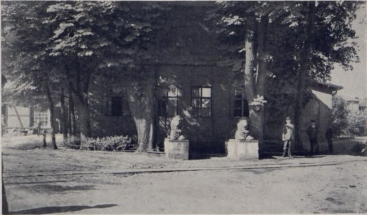
Altes Verwaltungsgebäude der Gleiwitzer Hütte, Portallöwe von Bildhauer Kalide (auf der Hütte gegossen)
