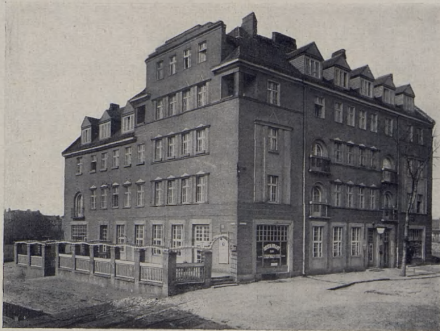
Wohn- und Geschäftshaus an der Stadtwaldstr. Ecke Schillstr. 33 in Gleiwitz (erbaut im Jahre 1925)
