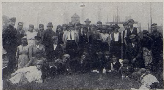
GLEISARBEITEN BAHNHOF BEUTHEN O.-S.
