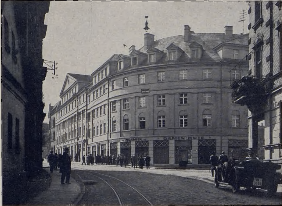
Städtische Wohnhäuser an der Niederwallstraße
