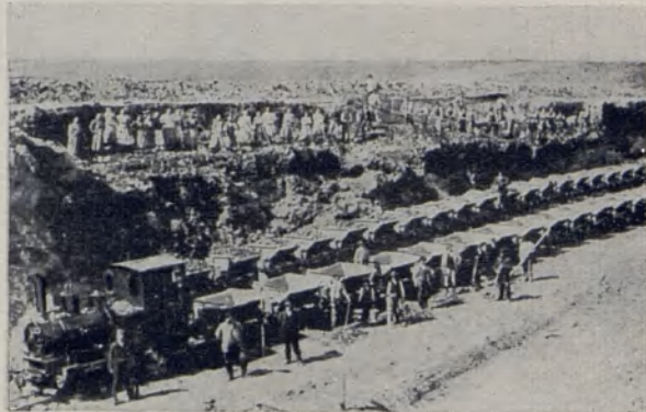
Bahnbau Bauerwitz—Troppau 1907/08; Los IV
