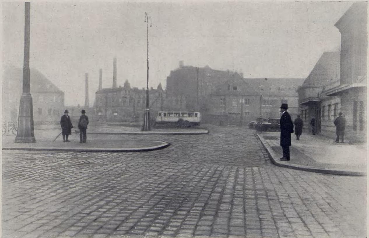
Pflasterarbeiten usw. für den Bahnhofsvorplatz Gleiwitz
