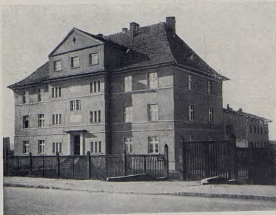
Wohn- u. Werkstoffgebäude und Lagerplatz der Fa Ogroske & Co., Gleiwitz, Tosterstr. 67
