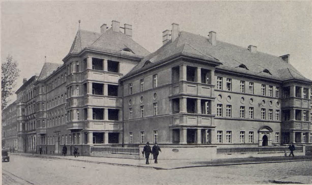
Beamtenwohnhäuser der Gräfl. Ballestrem'schen Verwaltung
