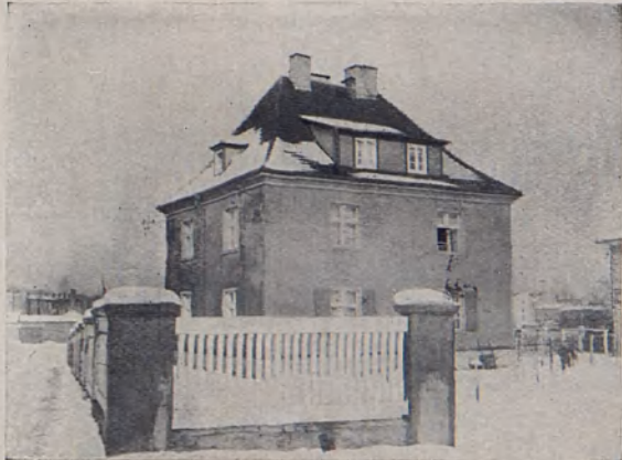
SIEDLUNGS-WOHNHAUS IN D. SIEDLUNG SUD IN GLEIWITZ, ECKE DAMASCHKE- STRASSE - SCHWALBENWEG, HERRN EX- PEDIENTEN JOHANN GORUS GEHORIG ERBAUT 1926
