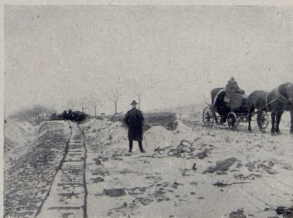
Ausführung des neuen Chausseebaues für das Kreisbauamt Groß-Strelitz OS. von Sacholna nach Dollna, 6 km lang. Hergestellt mit eigenem Kleinbahngerät und Pferdebetrieb.
