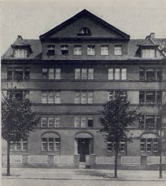
Beamtenwohnhaus der A. E. G., Gleiwitz, Friedrichstraße
