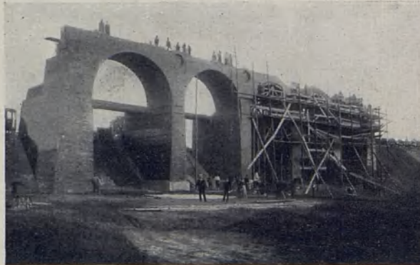
Eisenbahnbrückenbau bei Paruschowitz O.-S., 1910
