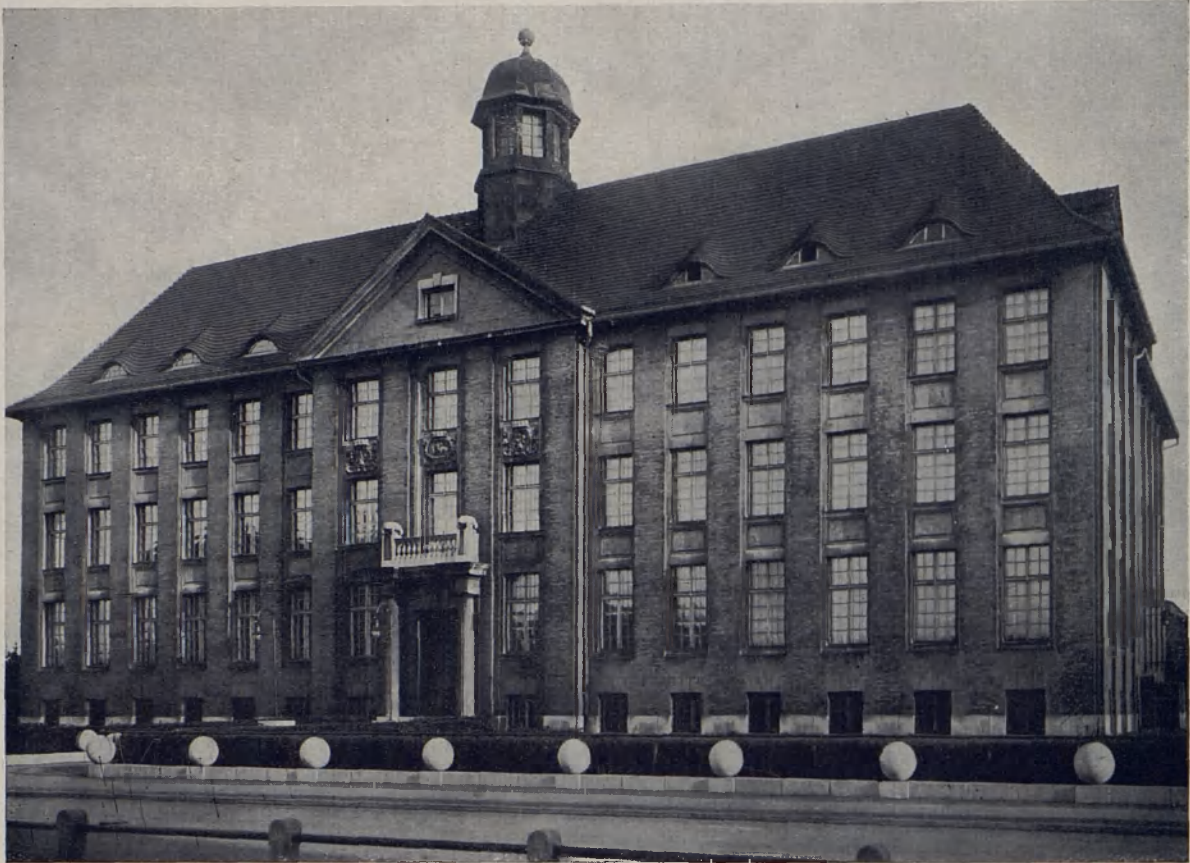
Verwaltungsgebäude der Bismarckhütte A. G., Bismarckhütte
