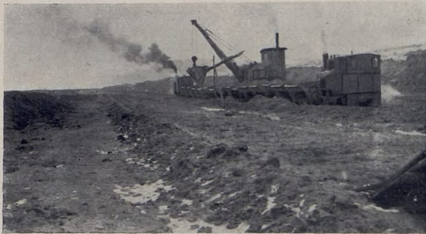
Sandbaggerei für Spülversatz
