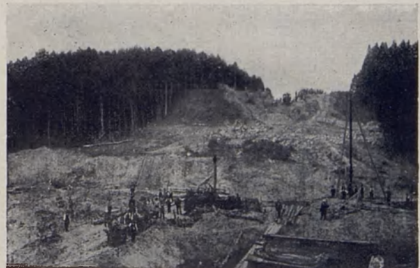
Eisenbahnbau Czersk—Laskowitz Westpr. 1905. Gewölbter Durchlaß
