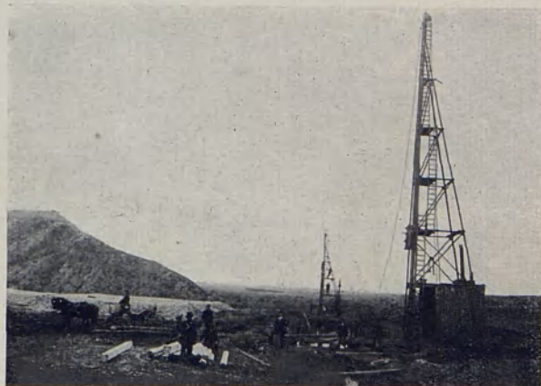
Eisenbahn-Neubaustrecke Hultschin—Dt. Krawarn 1911/12, Los 1. Brückenbau (Pfahlrostgründung) Station 142+77
