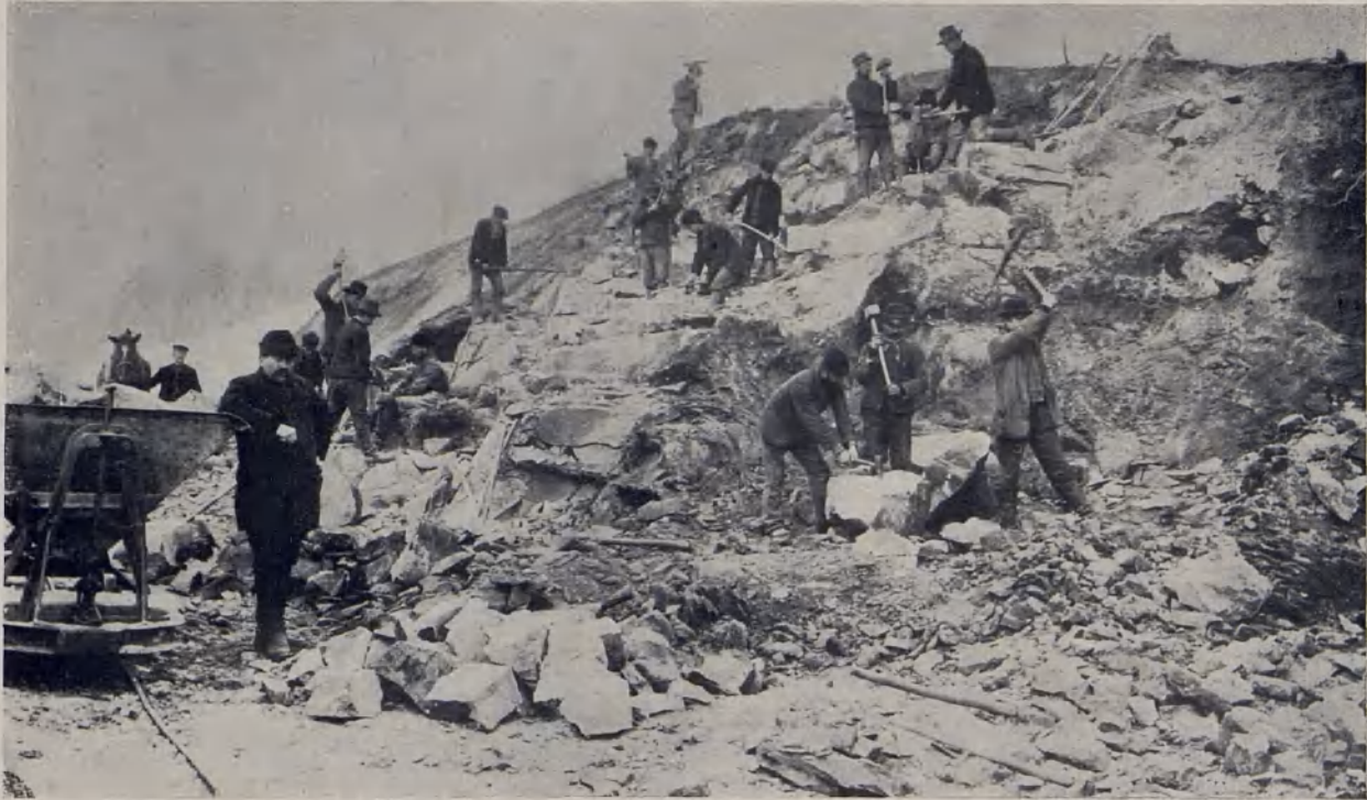
Chausseebau Steinkirch-Pogarth, Kreis Strehlen. Durchgesprengter Felskegel bei Stat. 5.6. Ausführung: Johann Kohla
