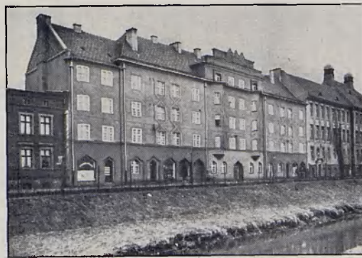
Wohnhaus Koban, Kaltbadstr. 1926-27
