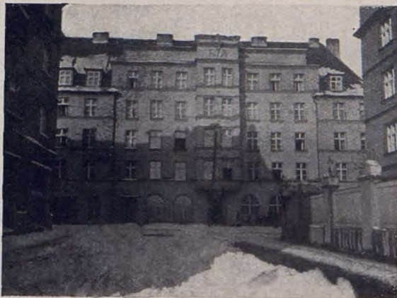
GROSSERES WOHNHAUS MIT CAFÉ AUF DER BRESLAUER STR 18. u. 20, GLEIWITZ, HERRN WIRTSCHAFTS-INSPEKTOR E. RUPPRICH GEHORIG ERBAUT 1927
