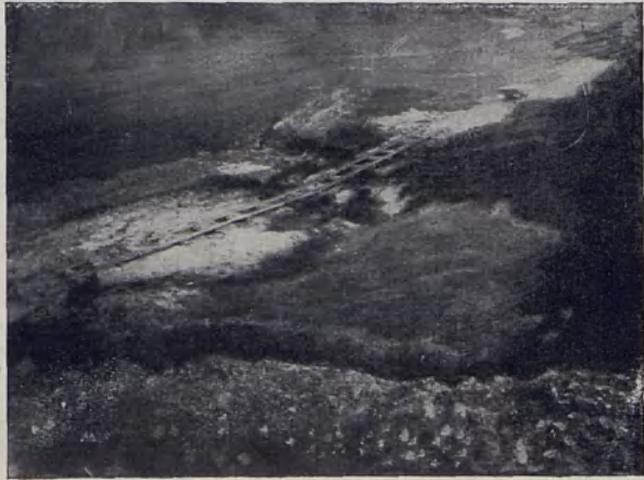
Chausseeneubau Kieferstädtel—Deutsch-Zernitz (Bergrutsch)
