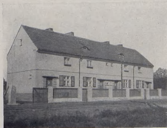
Vierfamilien-Wohnhaus der Reichseisenbahn auf Bahnhof Brynek O.-S.
