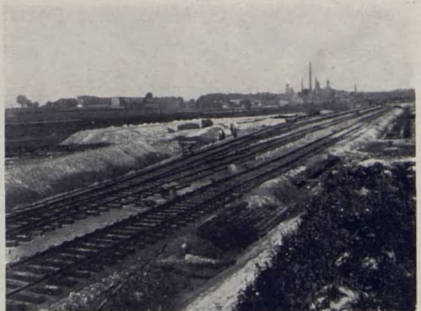
Gleisanschlußanlage der Dtsch. Blei-Scharleygrube bei Beuthen O. S.
