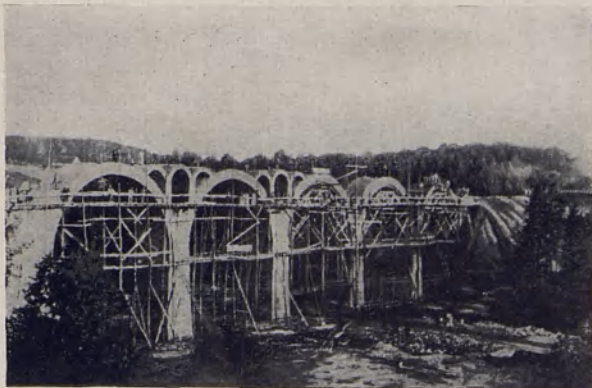
Eisenbahnbrücke über den Romintefluß
