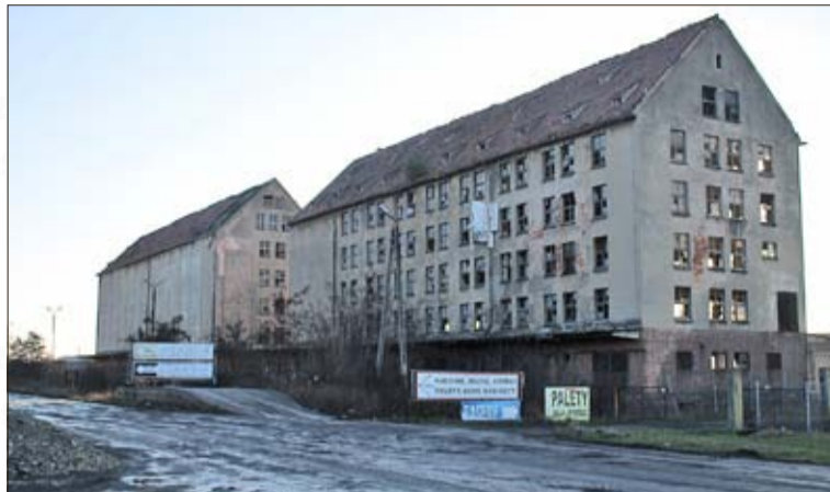
Pozostały już tylko dwa spichlerze na ul. Zbożowej w Opolu.
