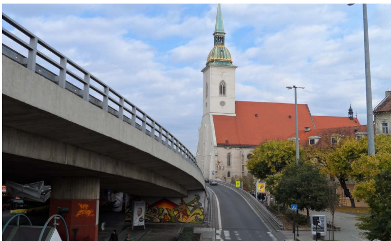
Il. 4. Widok Novego mostu w stronę katedry św. Marcina. (fot. M. Michałowska)
