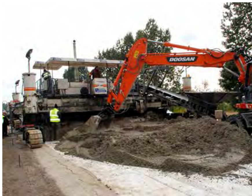
Przebudowa drogi krajowej nr 94. Fot. Urząd miasta w Dąbrowie Górniczej
