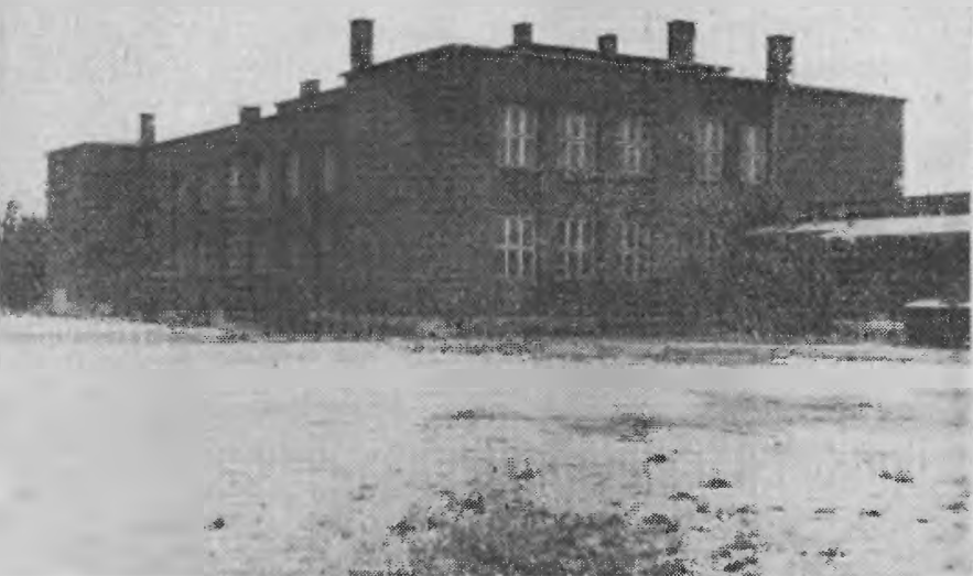
Szkoła Podstawowa Nr 2, zbudowana w 1933 r. Szkoła ta przejęła czynność Szkoły Kolejowej
