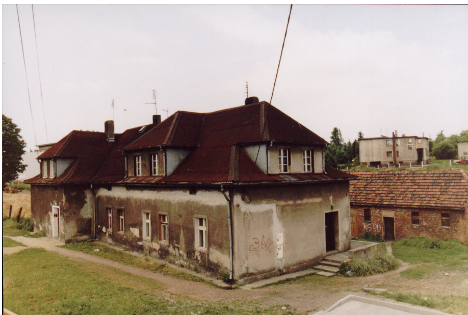
Budynek szybu Versuch (Tropiciel). Stan z 2003 roku.
