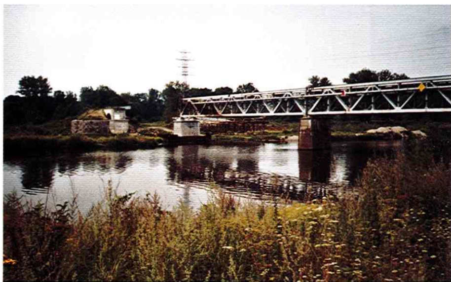
Die Eisenbahnbrücke in Krappitz
