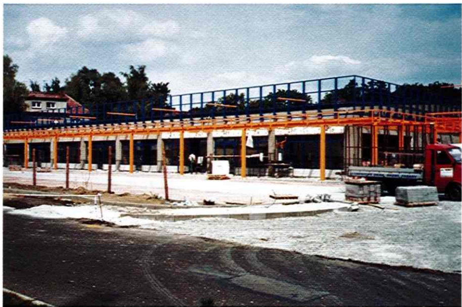
Baustelle Neustädter Straße „PLUS“
