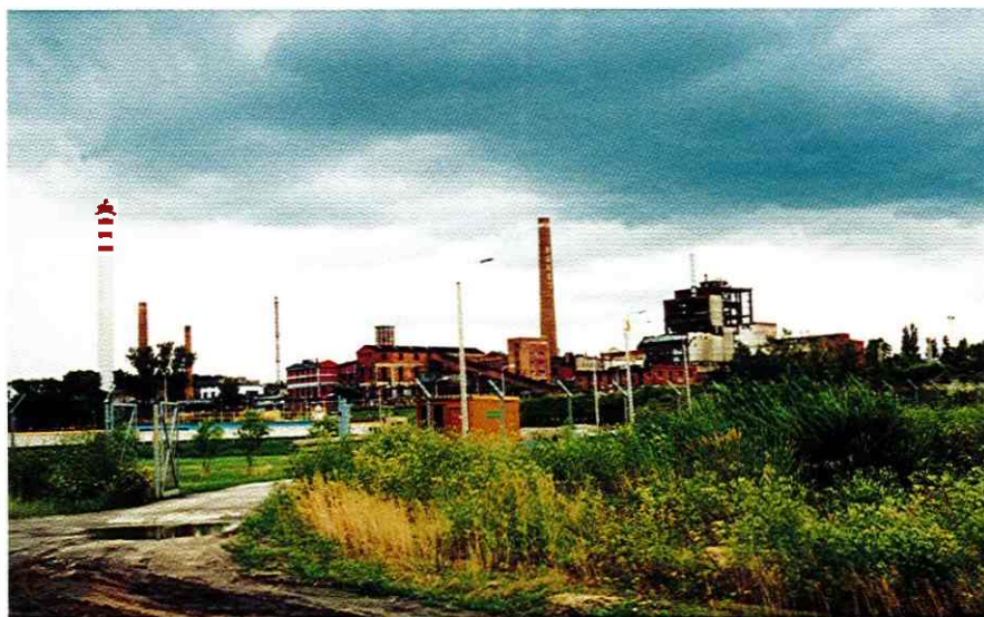
Die alte langsam untergehende Papierfabrik mit einem neuem Schornstein. Von der Rogauer Seite wird das Fabrikgelände scheibchenweise verakuft.
