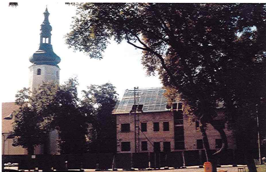
Ottmuth, neben der Kirche entsteht ein Pfarrhaus
