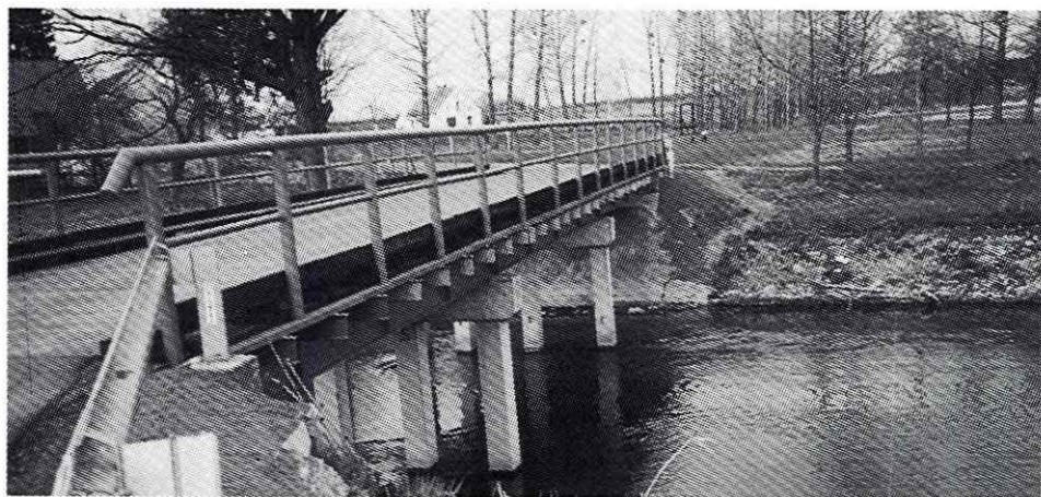
Die neue Hotzenplotzbrücke auf den Wiesen zwischen Stöblau nach Teichgrund/Pietna (Foto: April 2000)
