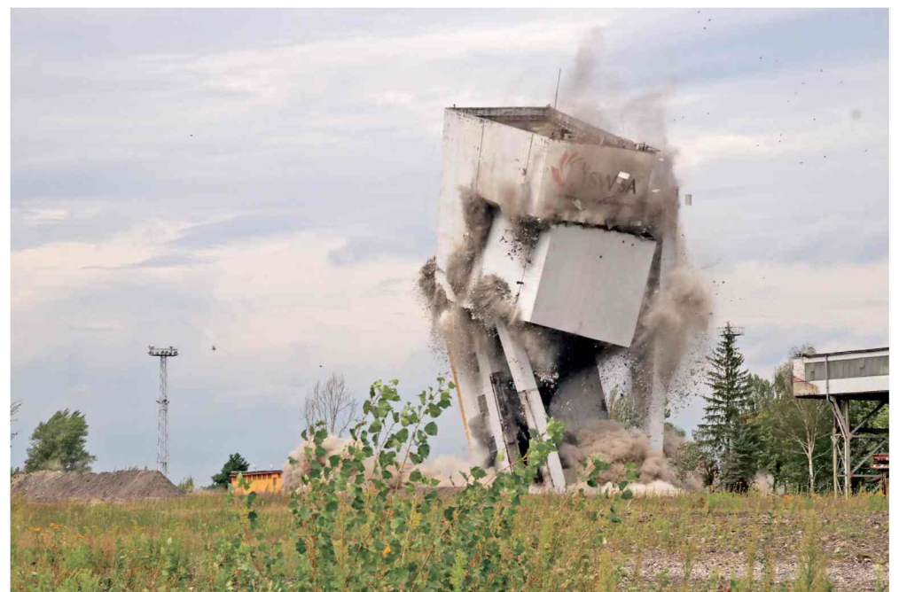
■ Wyburzenie wieży szybowej Jas II po byłej KWK Jas-Mos. 19.08.2026 r.
