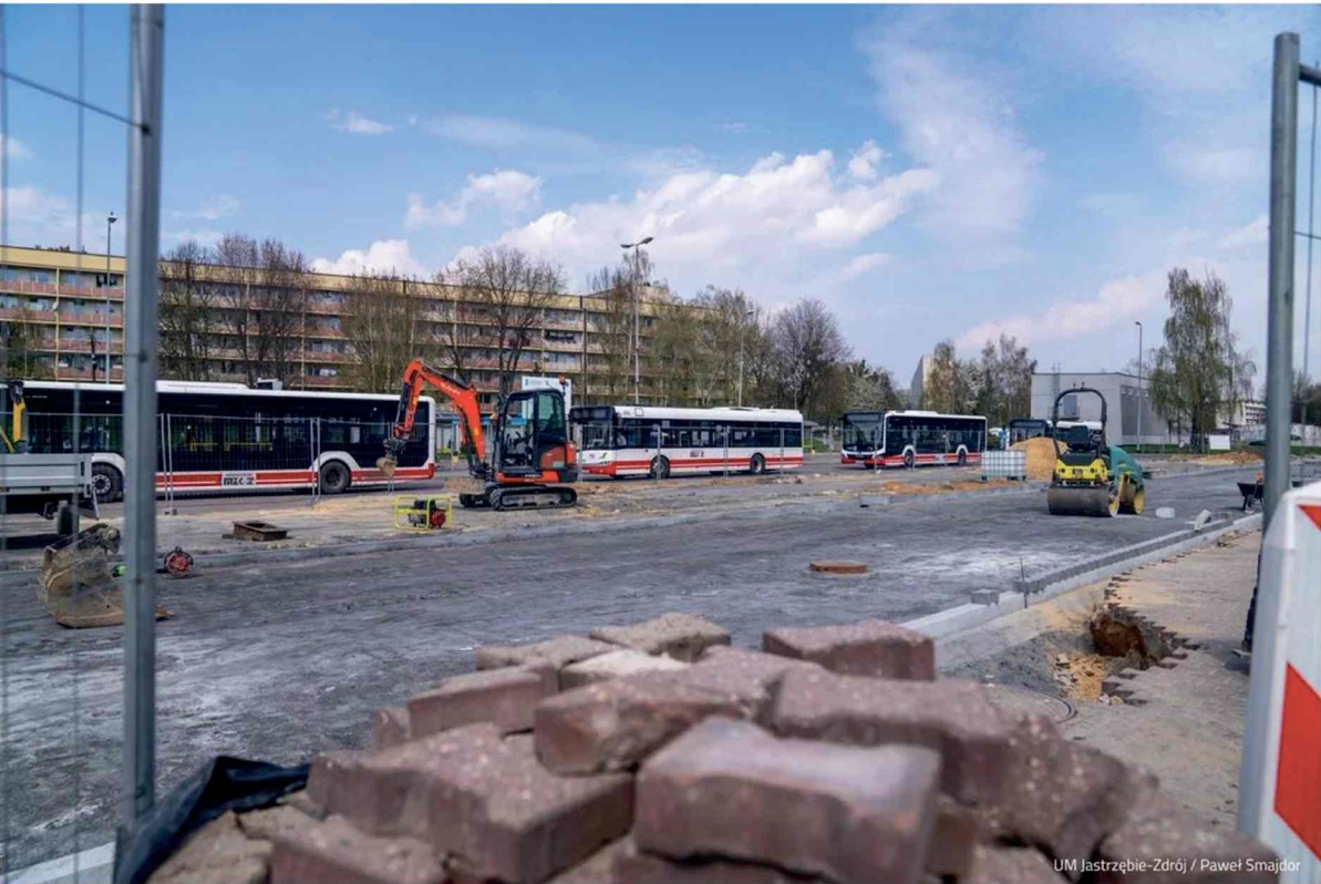
■ Trwa weryfikacja ofert wykonawców drugiego etapu inwestycji w Jastrzębiu-Zdroju. FOT. UM JASTRZĘBIE-ZDRÓJ
