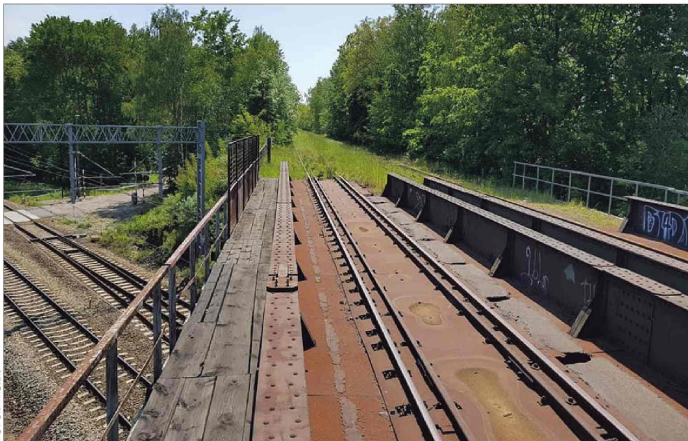
■ Kiedyś kursowały tędy pociągi, w przyszłości pojadą rowery. Rybnik rozpoczął procedurę wyboru wykonawcy велоstrady.
