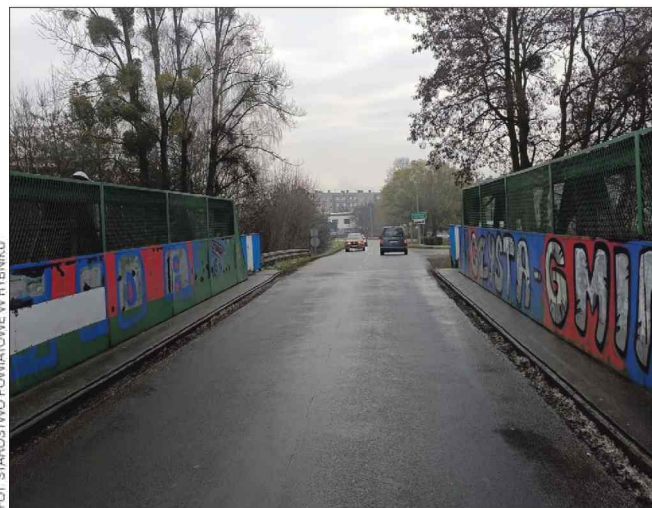
■ Wiadukt w Leszczynach do zamknięcia od maja. Kierowców czeka ponad rok utrudnień.
